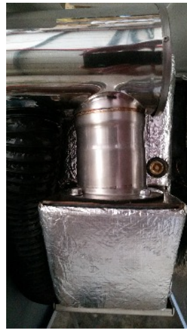
2. LOW LEVEL SIDE OUTLET FLUE. KIT PT.NO. FL80LLSO
